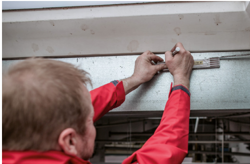
1.) Positionierung der Halterung gemäß der Tabelle
