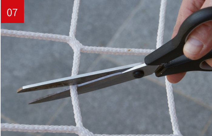
07 Wenn erforderlich, Masche mit Schere durchschneiden für den Zylinder
