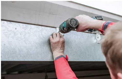
2.) Befestigung der Halterungen mittels gelieferter Schrauben
